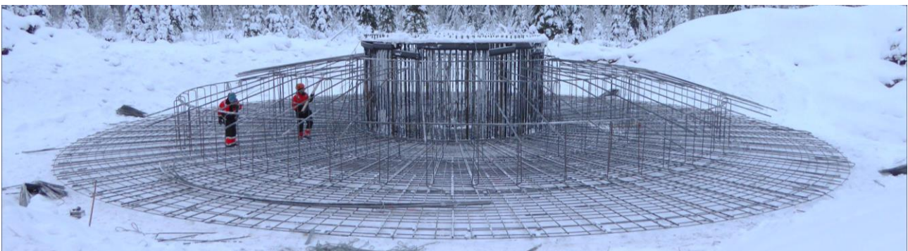
Kuva 4: Tuulivoimalan perustuksen raudoitusta.
