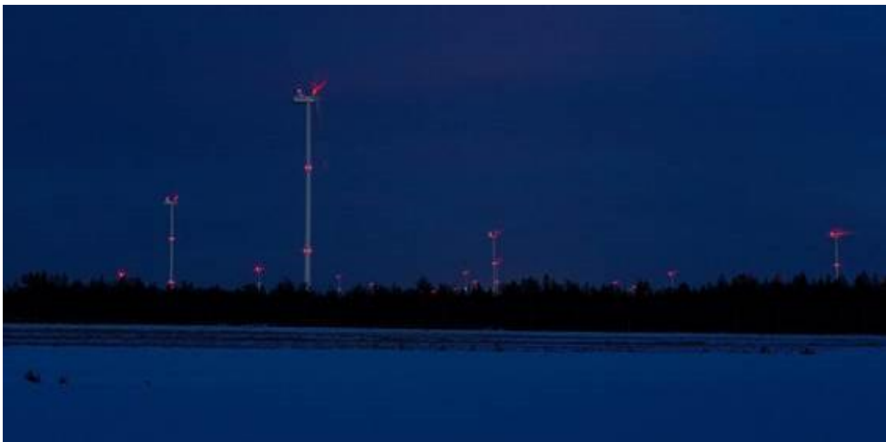
Kuva 2-3: Kiinteät punaiset lentoestevalot. (Kuva: FCG)
