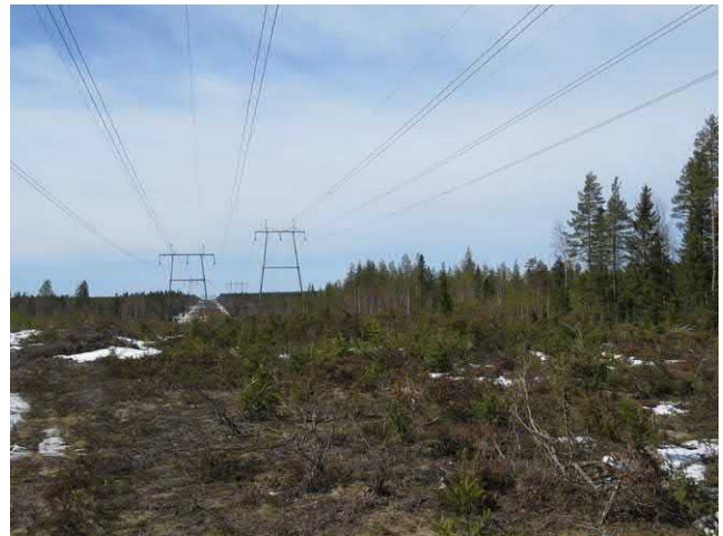
Kuva 43. Linja Kellovaaran pohjoispuolella, länteen.
